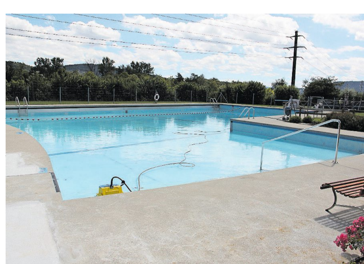
Das Hauptschwimmbaden hat Lecks. Bild: cm (Villnachern, 5. Juli 2020)
