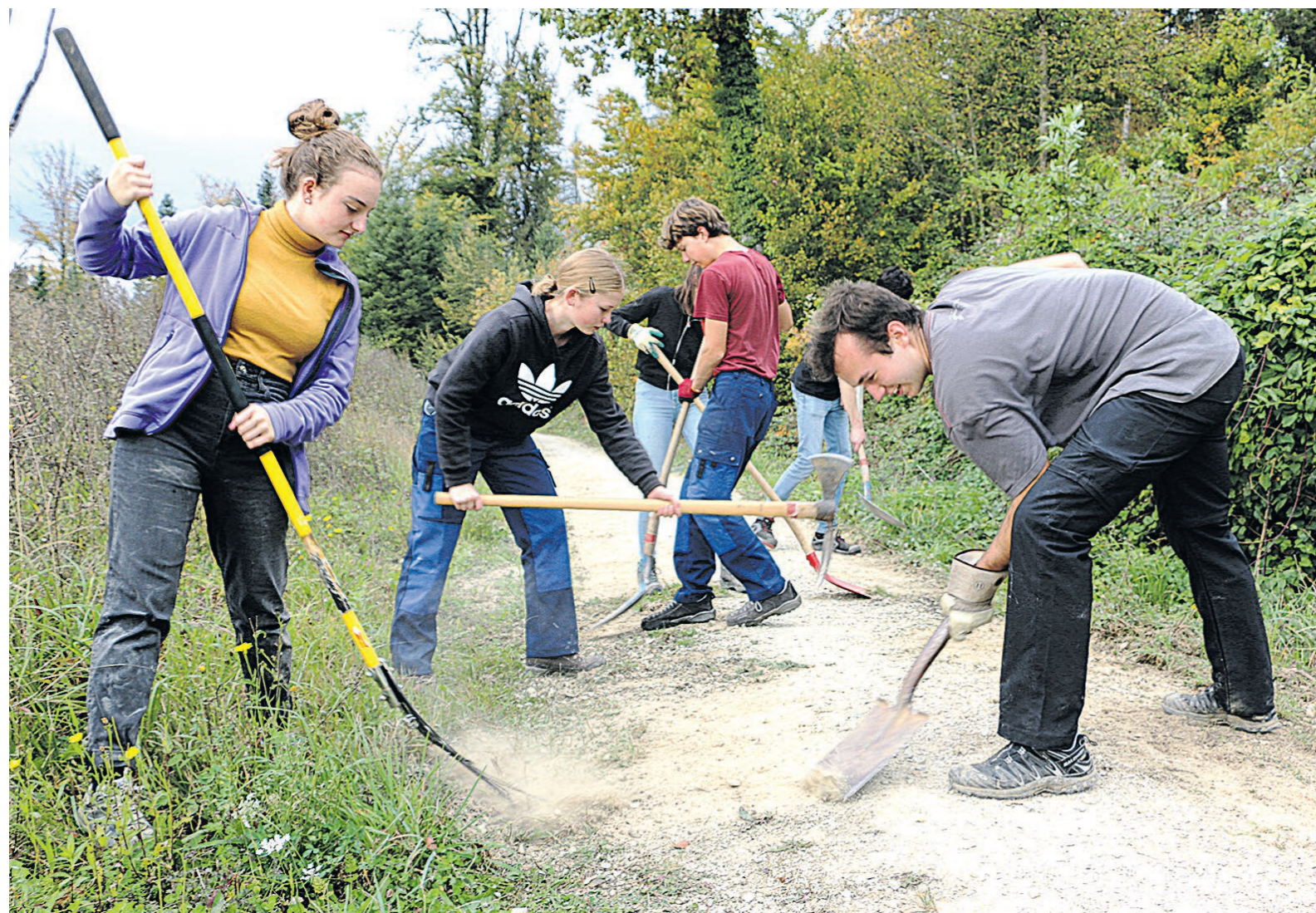
Voller Einsatz auf dem Gelände des SwissFEL.
