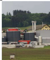
Industrial WWTP Rickenbach (LU) © Gefu Produktions
